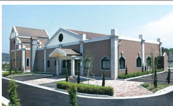
南あわじ市広田浄化センター 外観
