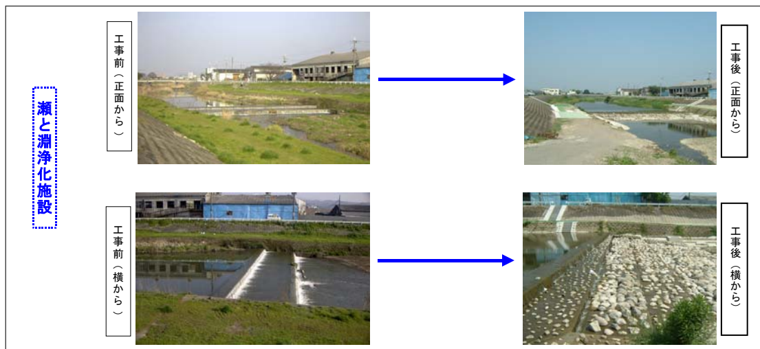
図 4-14 河川浄化施設設置状況（樫井川 瀨と淵浄化）
