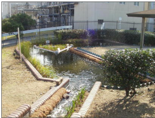
水生植物設置状況
