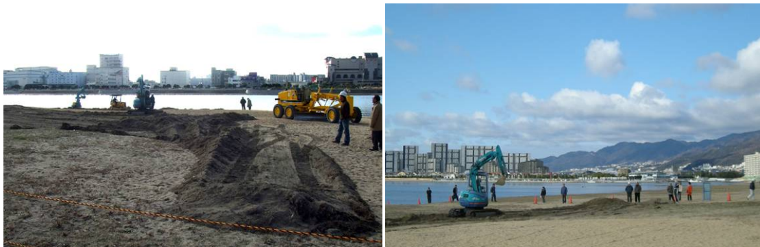
砂浜再生実験の様子
