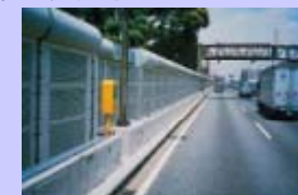
遮音壁の設置
