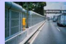
遮音壁の設置
