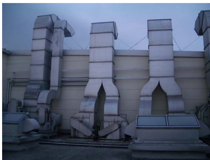
排気口群(印刷機械ごとの排気口)
