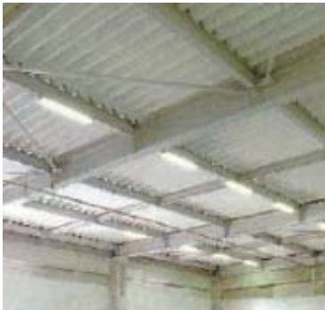
屋根用折板石綿断熱材 （レベル2）
