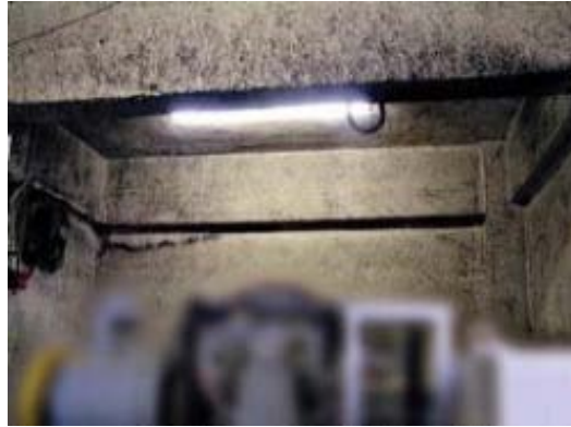
機械室吸音材（レベル1）
