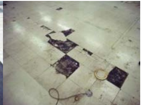
石綿含有ビニル床タイル （レベル3）
