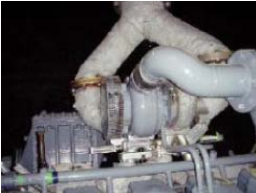
配管エルボ部分の保温材（レベル2）
