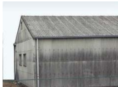
石綿含有スレート波板（レベル3）
