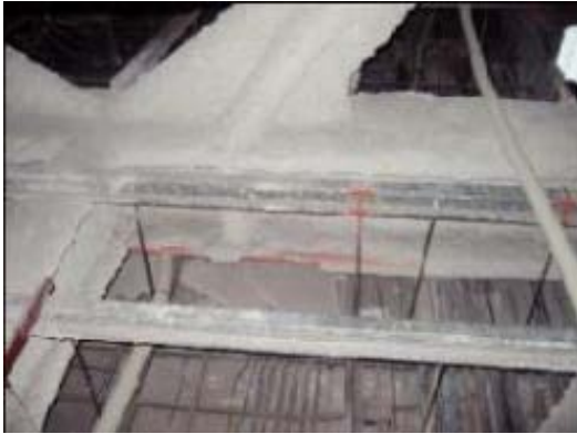
鉄骨耐火被覆材（レベル1）
