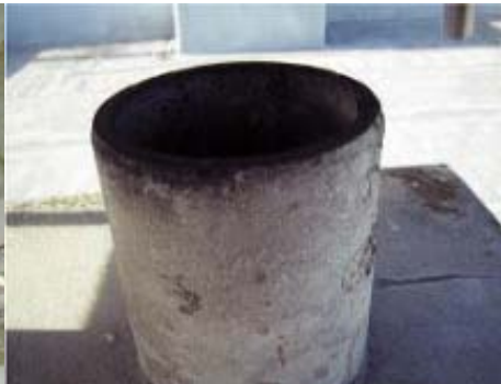
煙突用石綿断熱材 （レベル2）
