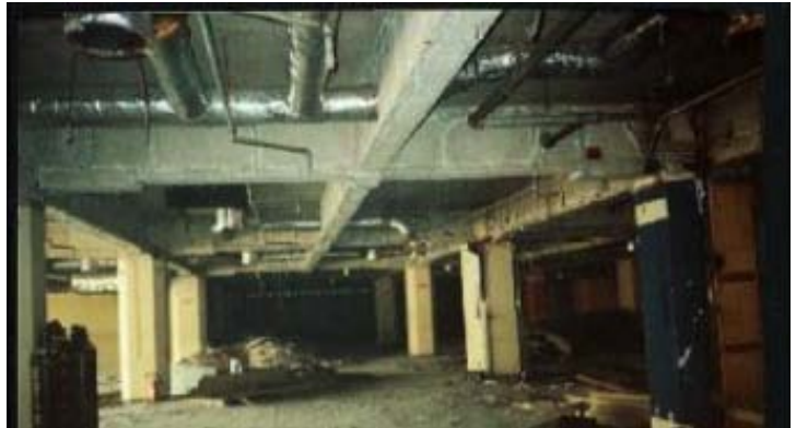
鉄骨耐火被覆（レベル2）
