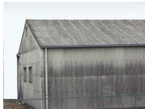
石綿含有スレート波板（レベル3）
