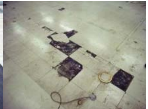
石綿含有ビニル床タイル （レベル3）
