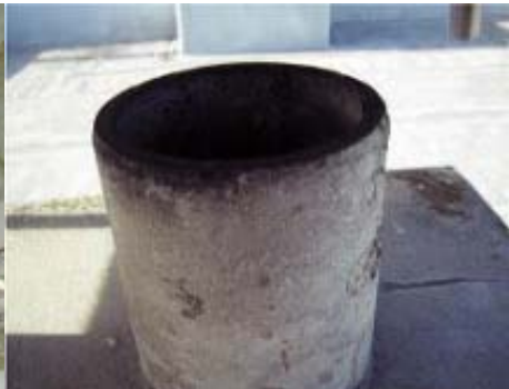
煙突用石綿断熱材 （レベル2）
