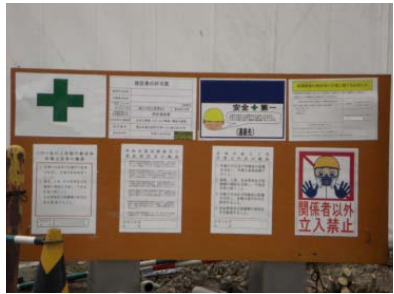
ホテル 機械室に吹き付け岩綿・配管に保温材など考えられるが成形板等のみの解体現場という表示になっている。
