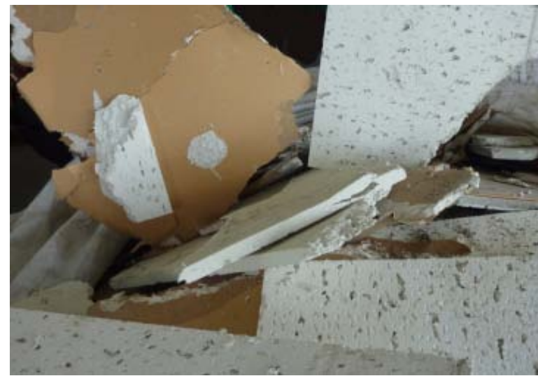
岩綿吸音板・石膏ボード天井2重張りの解体残材(手ばらしでの解体が出来ない状況)
