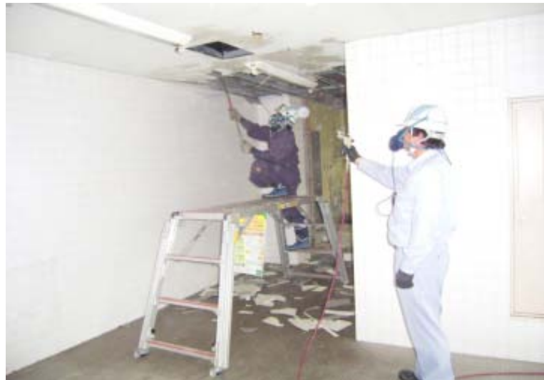
石綿含有建材(フレキシブル板)のバールによる破砕作業(手ばらしではない)
