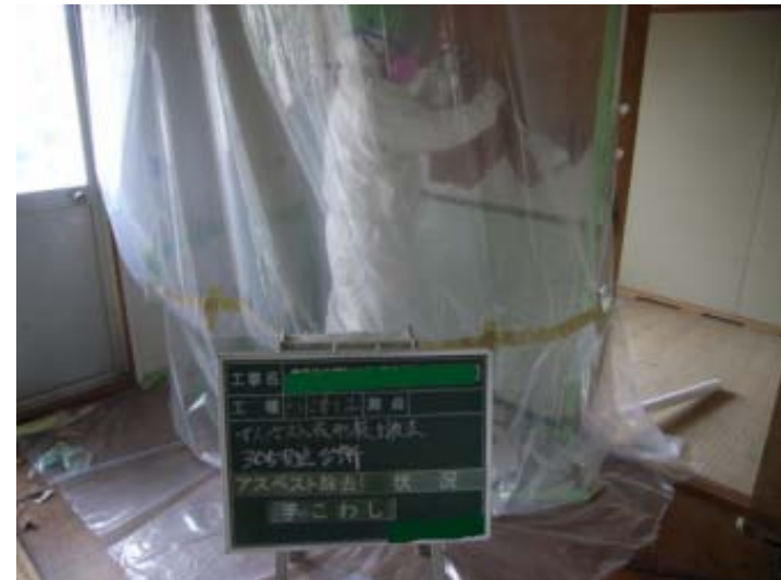
石綿含有建材のバールによる破砕作業(手ばらしではない)安全対策先行事例
