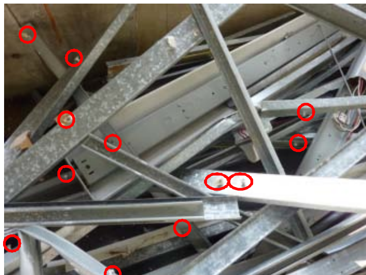
手ばらし解体ではない。ビスが軽天材にそのまま残っている。
