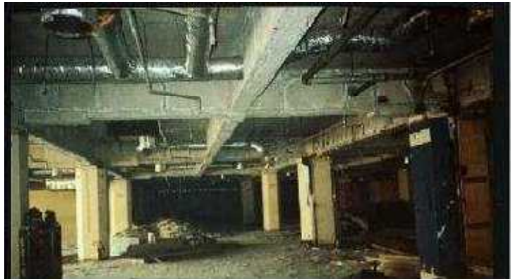
鉄骨耐火被覆 (レベル2②)
