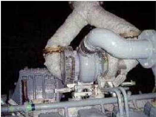
配管エルボ部分の保温材 (レベル2①)
