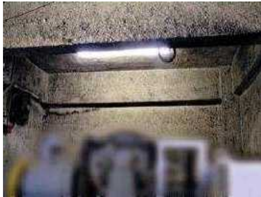
機械室吸音材 (レベル1②)
