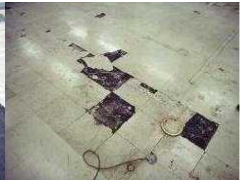
石綿含有ビニル床タイル (レベル3①)
