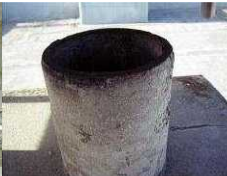
煙突用石綿断熱材 (レベル2③)
