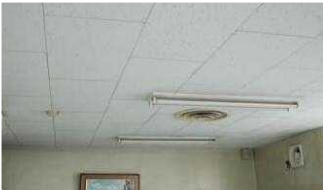
石綿含有ロックウール吸音天井板 (レベル3①)
