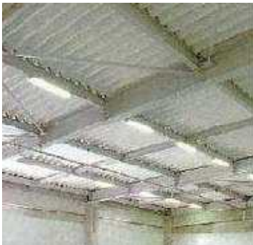
屋根用折板石綿断熱材 (レベル2③)
