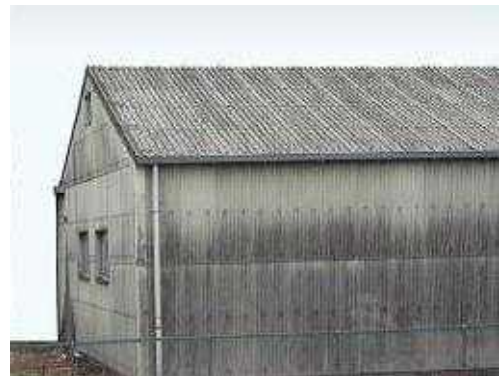
石綿含有スレート波板 (レベル3②)
