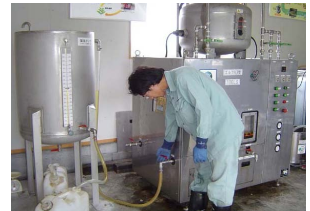
廃食油のBDF精製装置
