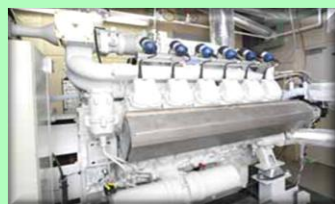
【ガス化発電施設】
