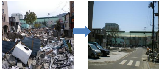
(釜石市内のガレキの撤去状況)
