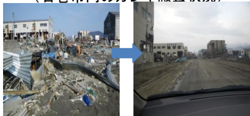
(石巻市内のガレキ撤去状況)
