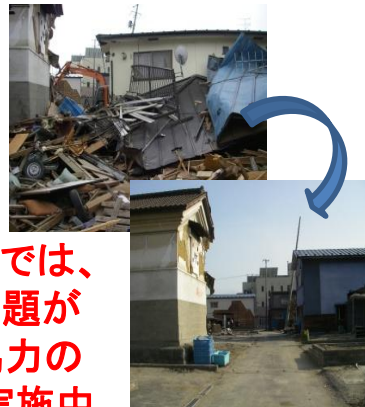
(撤去前と撤去後(宮古市))
