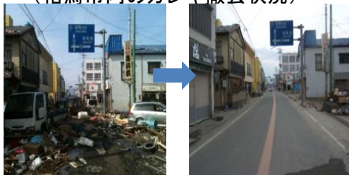
(相馬市内のガレキ撤去状況)
