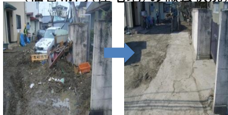
(仙台市内(住宅地)の撤去状況)
