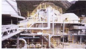
木くずだきボイラー
