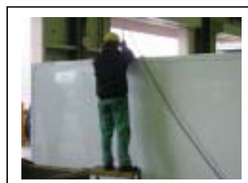
③-2 天井の取外し
