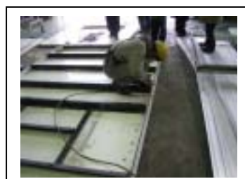
⑧-1 根太材の取外し
