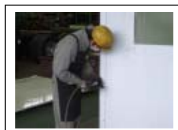
④ 前壁の取外し
