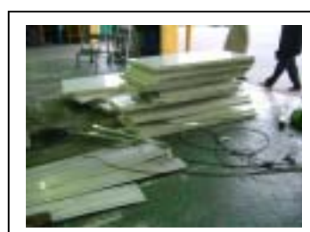
⑩ 断熱パネルの解体
