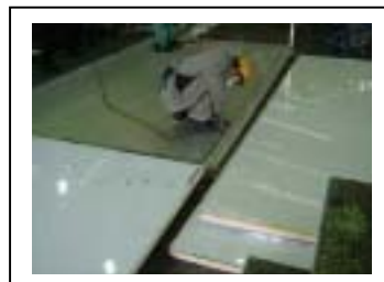
⑥ 床材の取外し
