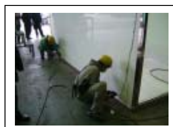
⑤-1 側面壁の外し
