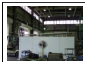
③-3 天井の取外し
