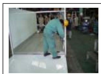
⑤-2 側面壁の取外し
