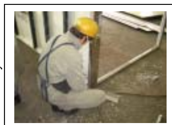
⑦-2 リヤドア枠の取外し
