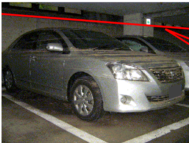
壁面の泥の付着から推定される水位
