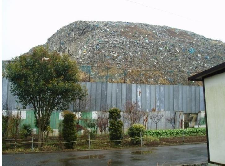
廃棄物処分業（破碎）、収集運搬業の許可を有するA事業者が、中間処理施設（破碎施設）敷地内に、平成14年頃から廃棄物（中間処理前及び中間処理後のもの）を不適正に保管（廃プラスチック類、木くず等を約50,000m<sup>3</sup>（面積約6,400m<sup>2</sup>、高さ約18m））。
