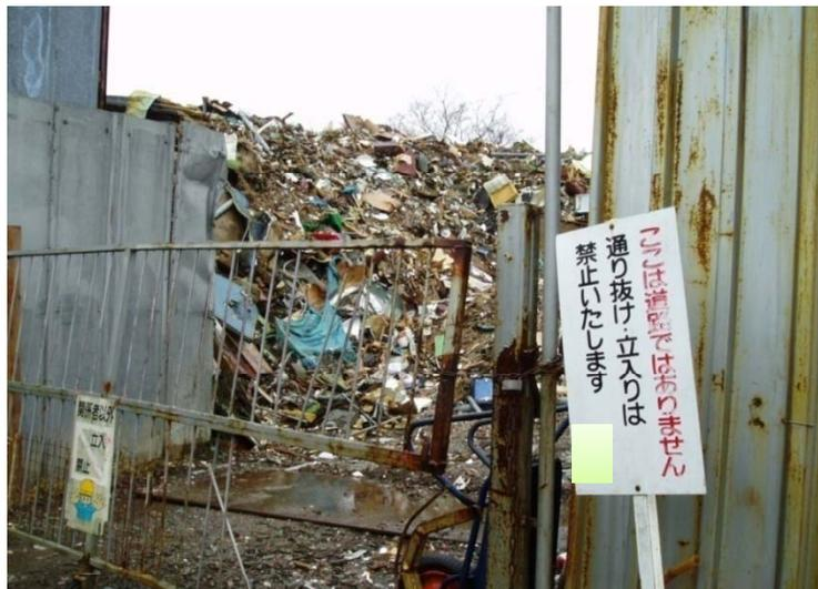
土木建設業かつ解体工事業を営むA社が、家屋解体工事等に伴い生じた建設系廃棄物を約7年間にわたり、自社の資材置場に不適正に保管(約3500m<sup>3</sup>、面積850m<sup>2</sup>、高さ10m)。
