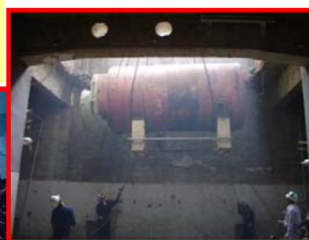
建築設備の取り外し
