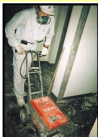
アスベスト含有形成版撤去
