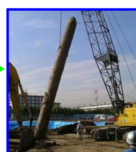
基礎及び基礎杭の撤去 - 21 -
