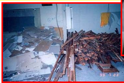
内装材(木材・廃石膏ボード)の分別
