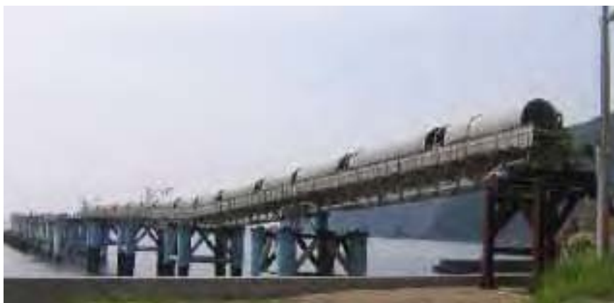
再使用先の栈橋
