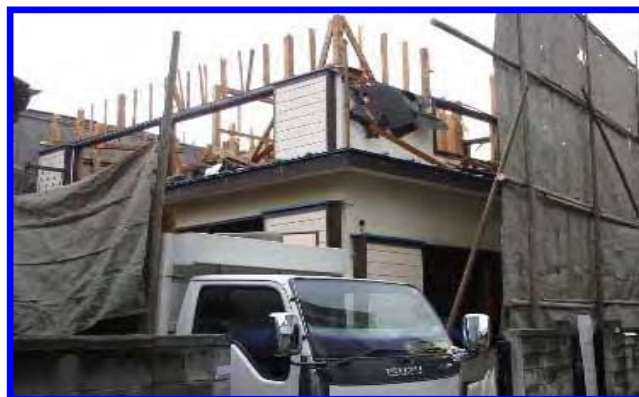
上家の解体(外装材、梁、柱等の取り壊し)
