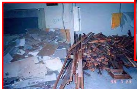
内装材(木材・廃石膏ボード)の分別
