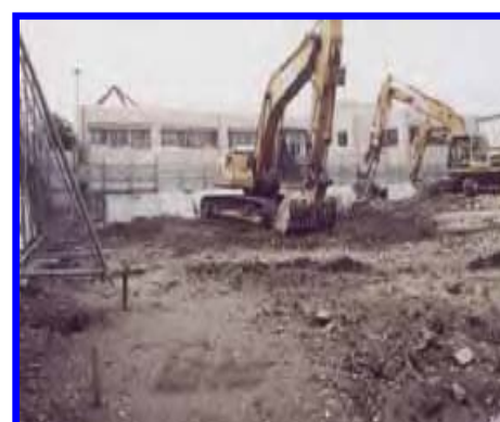
基礎及び基礎杭の取り壊し
