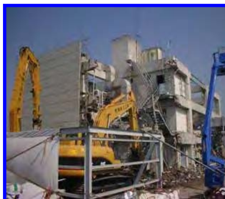
躯体の解体(屋根、外装材、構造体を同時に取り壊し)
