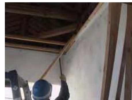
幅木除去の状況
