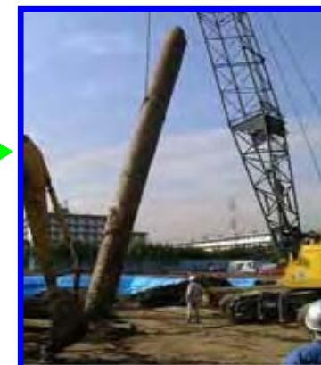
基礎及び基礎杭の撤去 20
