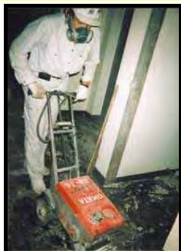
アスベスト含有形成版撤去
