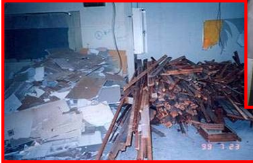
内装材(木材・廃石膏ボード)の分別
