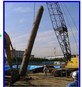
基礎及び基礎杭の撤去
