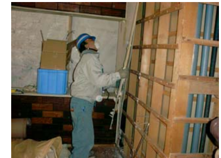
分別解体状況
