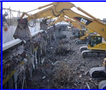
躯体の解体(屋根、外装材、構造体を同時に取り壊し)
