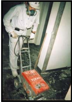
アスベスト含有形成版撤去
