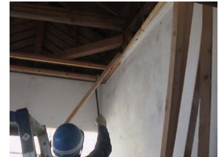
幅木除去の状況
