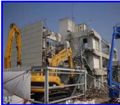
躯体の解体(屋根、外装材、構造体を同時に取り壊し)
