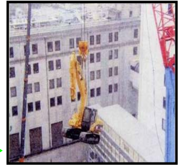
クレーンで重機を揚重して屋上に設置
