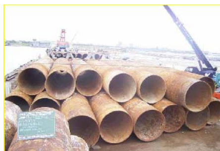
撤去された棧橋の鋼材
