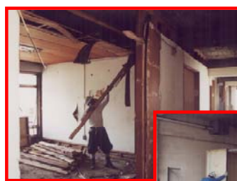
内装材の取り外し ※写真は石綿非含有建材
