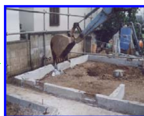
基礎の取り壊し (基礎杭がある場合も取り壊し)
