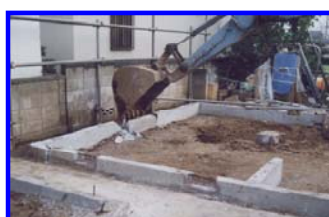
基礎の取り壊し (基礎杭がある場合も取り壊し)
