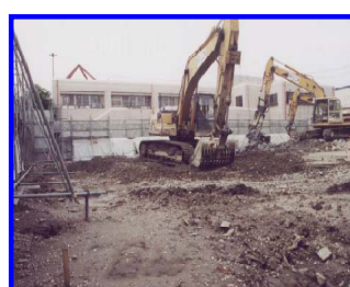
基礎及び基礎杭の取り壊し
