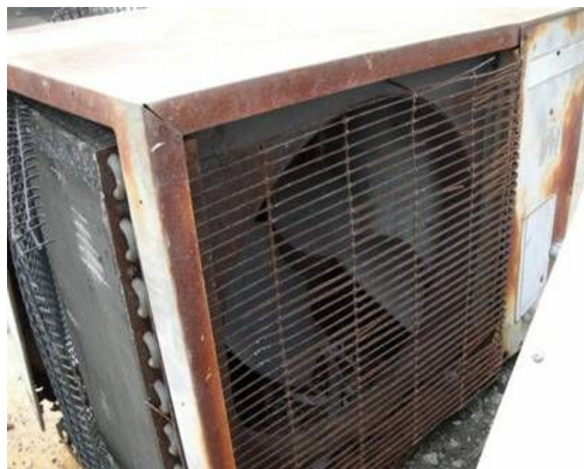
【著しくさびが付着した室外機】
