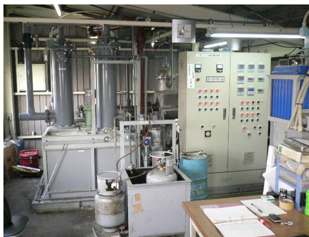
プラズマ破壊処理装置
