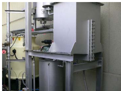
液状フロン回収タンク
