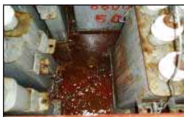
【図1 過去のPCBの劣悪な保管状況】
