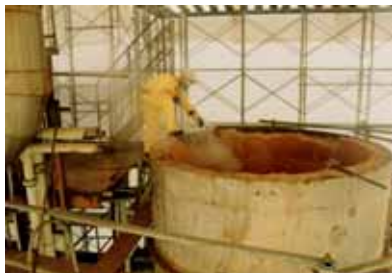
焼却施設の汚染物除去（除染） 解体の状況
