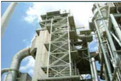
エコセメント製造施設 (千葉県)
