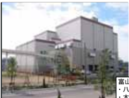
RDF 発電施設 (大牟田市)
