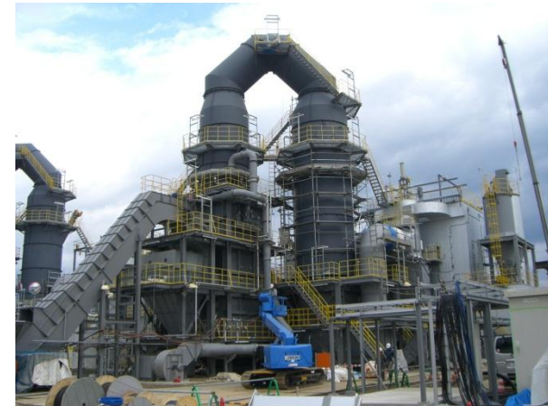
仮設焼却炉建設工事の様子 (11月、相馬市)
