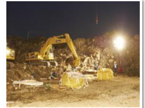
2011.12 夜間作業の様子 (宮城県石巻市)
