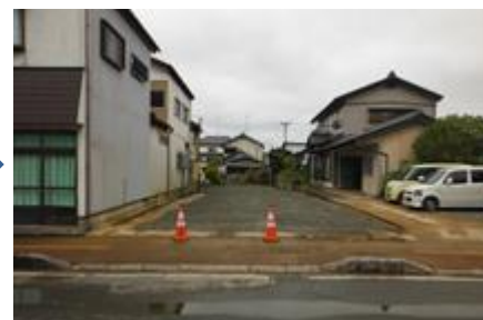
(解体事業実施後)
