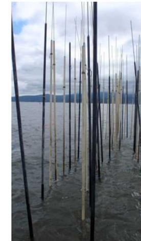
コンポーズは流軸に対し鉛直方向に70°傾けて設置
