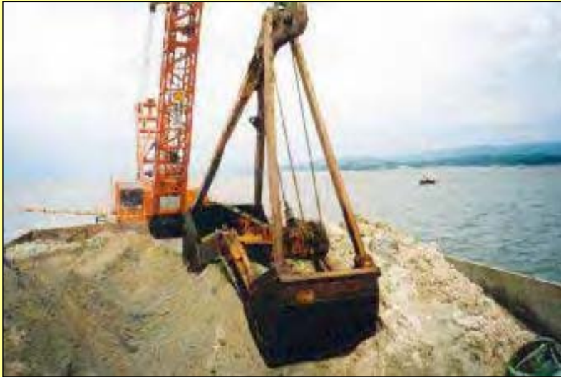
覆砂施行状況
