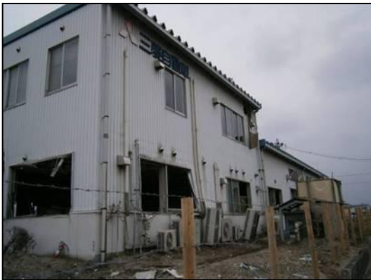
（流通ターミナル：室外機は押し潰され、室内機も天井から垂れ下がる）
