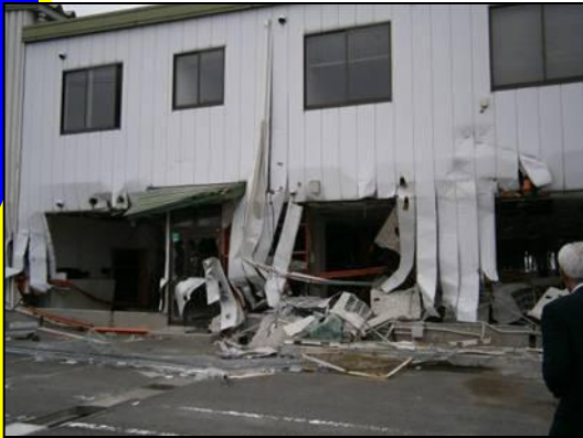
（流通ターミナル：室外機は押し潰され、室内機も天井から垂れ下がる）
