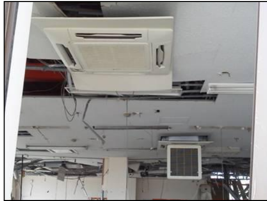
（流通ターミナル：室外機は押し潰され、室内機も天井から垂れ下がる）
