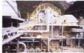
木くずだきボイラー
