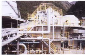
木くずだきボイラー
