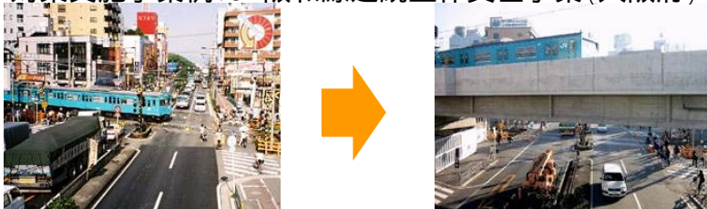
整備前後でのJR阪和線(長居南1踏切)の状況
