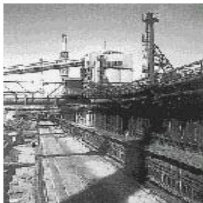
コークス炉で廃プラスチックを熱分解し、得られた軽質油や水素ガス、コークスなどを利用する技術
