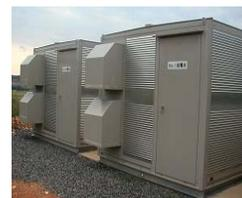
キャパシタ（風力発電などに併設して出力変動の準化を行うもの。）
