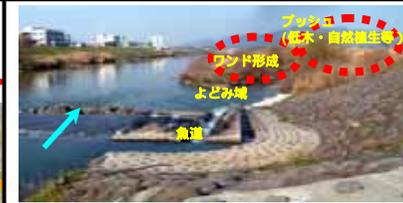
河川の上下流方向及び河川と流域との連続性を確保するための魚道整備、段差解消等を実施
