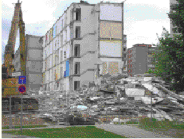
建築物の解体風景
