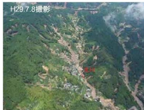
H29.7.8撮影 北川上流の崩壊状況(花崗閃緑岩が主)
