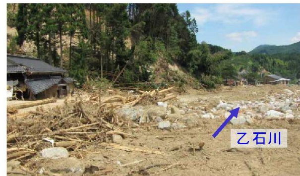
河道を閉塞した大量の土砂
