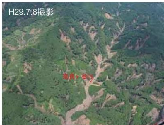
H29.7.8撮影 奈良ヶ谷川上流の崩壊状況(変成岩類が主)
