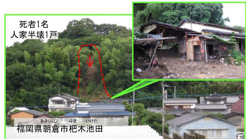
平成24年7月豪雨時のがけ崩れによる被害状況
