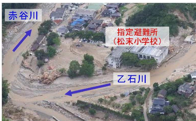
土砂・流木により被災した避難所
