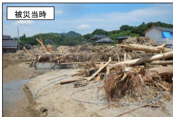
橋梁の閉塞状況 (赤谷川)
