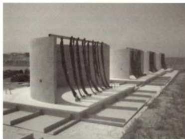
図 5.17 鎌早湾に設置された流況制御ブロック
