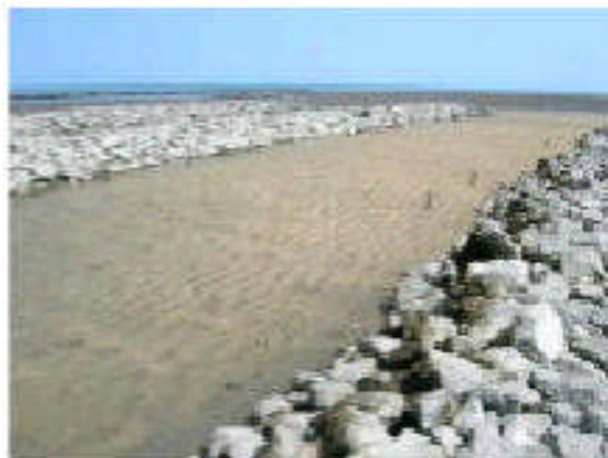
写真-1 台風通過後の状況(H17.9.16)
