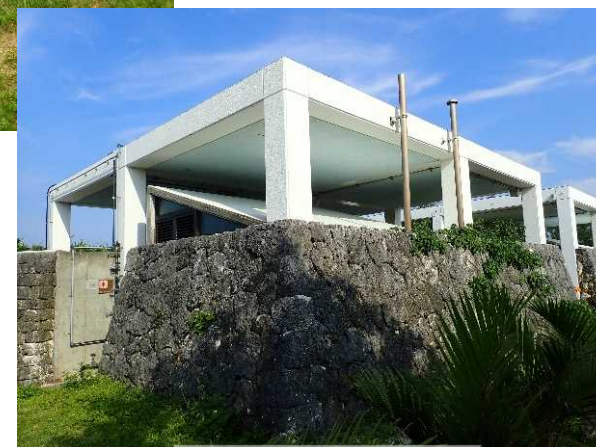
トイレ・シャワー棟
