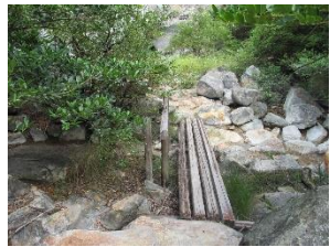
老朽化した木製橋
