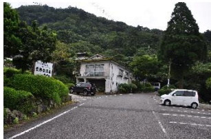
駐車場入口が狭く、公衆トイレがない
