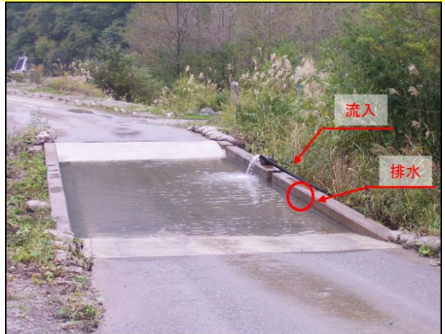
工事車両のタイヤの洗淨水槽
