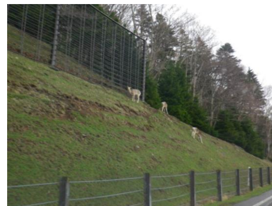
採食と踏圧による道路法面の損傷
