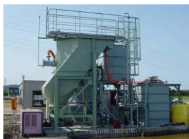
④ 排水処理
