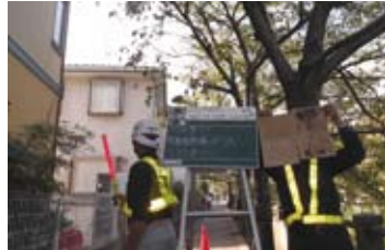
粘着板の交換作業
