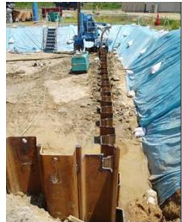
写真3-1 遮水壁(鋼矢板)の打設状況
