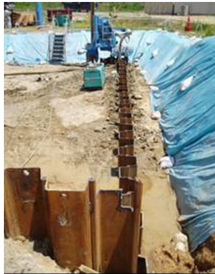
写真3 遮水壁(鋼矢板)の打設状況
