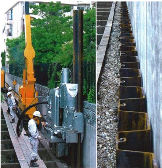
写真3 遮水壁(鋼矢板)の打設状況
