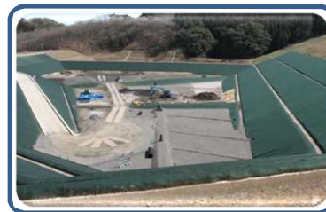
埋立処理施設(36施設)
