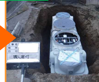
合併浄化槽設置
